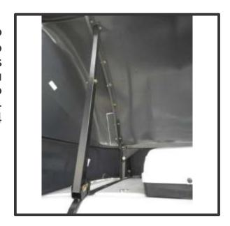
14) Após fixar o teto na altura ideal, fazer a furação das laterais do teto utilizando broca 9mm e fixá-las com 4 parafusos 8x25mm fenda cruzada pretos, 4 arruelas de chapeador 8mm e 4 porcas travantes 8mm. Posicionar as barras extensoras n°10 e 11 utilizando o arafuso das barras de regulagem de altura e o parafuso da lateral previamente furado. Utilize 2 parafusos sextavados 6x16mm, 2 arruelas isas 8mm e 2 orcas 6mm simples para dar a regulagem das barras extensoras.
